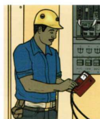
Figura 21.35. Verificación de la ausencia de tensión.
